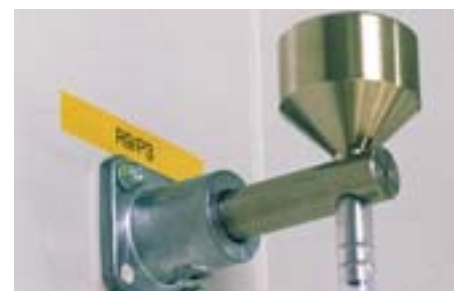
In jedem Raum und an jeder Werkbank sind Partikelsammler angebracht. Particle counters are installed in every room and at every work bench.
