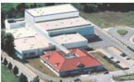
Das 1997 neu gebaute Aeropharm Werk in Rudolstadt liegt direkt neben dem alten Grundstück des 1876 gegründeten Unternehmens. Ein On-Line-Monitoring-System von Lufft sorgt jetzt für modernsten Produktionsstandard. The Aeropharm factory in Rudolstadt, newly built in 1997, lies directly alongside the original site of the Company, which was founded in 1876. An online monitoring system by Lufft now provides for state of the art production standards.
