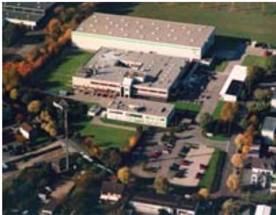
MADAUS Zentrallager in Troisdorf-Spich. Das schmale weiße Gebäude rechts ist der Explosions-Bereich mit dem Branntweinlager. The MADAUS central warehouse in Troisdorf-Spich. The small white building on the right is the explosive area with spirits store.
