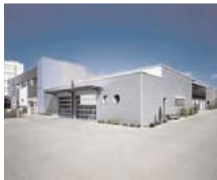
Biotest Abfüllgebäude. Die neue Sterilabfüllung und Verpackungsanlage gehört zu den modernsten ihrer Art in Europa. The Biotest filling building. The new sterile filling and packaging plant is among the most modern of its type in Europe.
