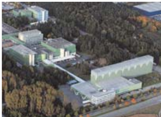
Werk Singen: Sterilstandort der ALTANA Pharma AG The Singen works: ALTANA Pharma AG's sterile plant.
