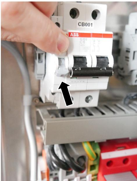
Abbildung 4 Schalterstellung für USV „ausgeschaltet“
