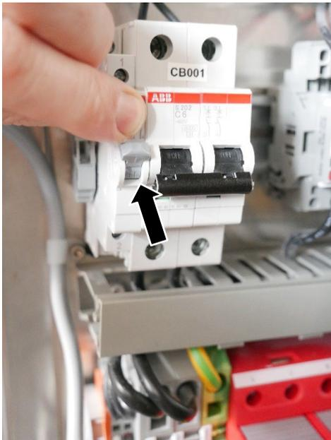
Abbildung 11 Schalterstellung nach oben, für USV „angeschaltet“
