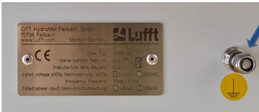
Abbildung 13 Erdungsanschluss am Sockel des Gerätes.
