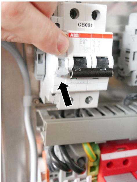
Abbildung 4 Schalterstellung für USV „ausgeschaltet“
