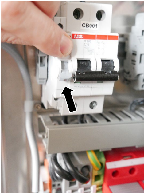
Slika 4: Položaj prekidača za isključivanje USP-a.
