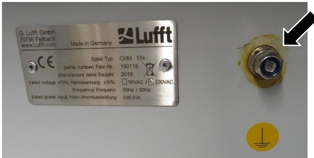
12. ábra Földelőcsatlakozás a készülék lábuzatán.
