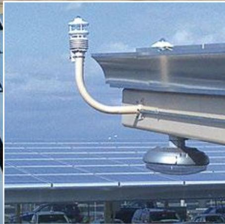
Wind kühlt die Temperatur des Moduls und muss deshalb in die Effizienz-Betrachtung einfließen. Niederschlag führt zu Verschmutzungen oder Bedeckung (Schnee).
